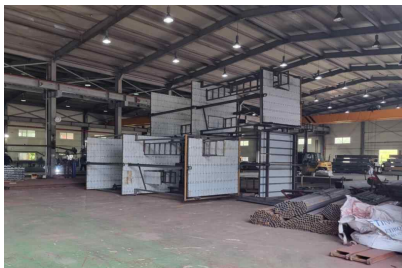
④ 발판+각재 용접
